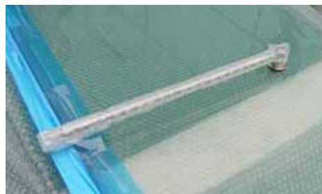
吊り材の保護
